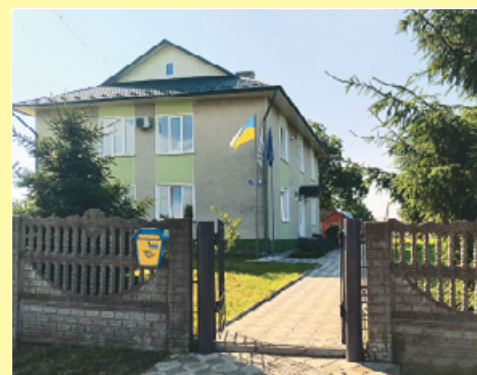
Адміністративна будівля Чернівецької філії УІЕСР, 2021 р.
